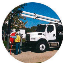
Aplicación de limpieza de alcantarillado
